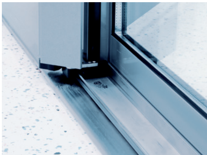
Izvedba podlage iz nerjavečega jekla
