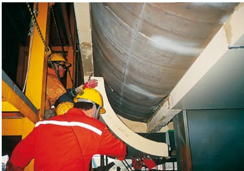
Obloge cevi iz visokokakovostnega izolacijskega materiala puren® PIR – popolna izolacija pri izredno nizkih in visokih temperaturah.
